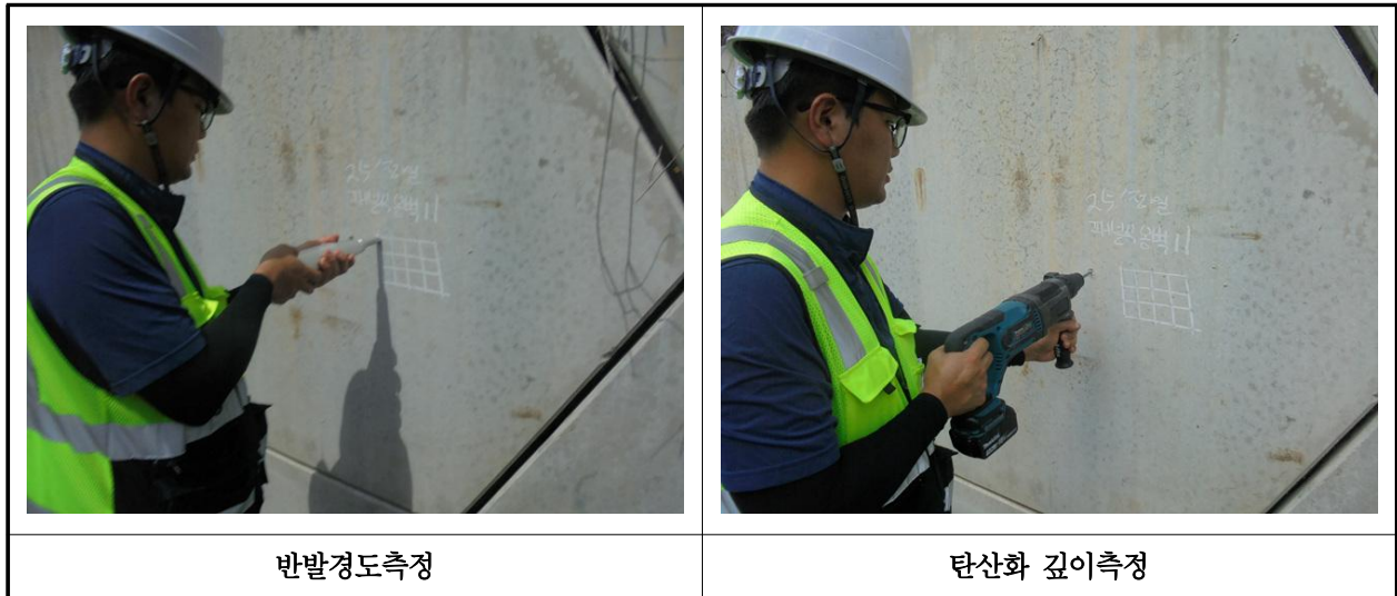
【사진 11.4.1】 재료시험 조사 전경
