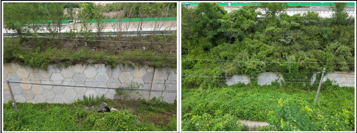
【사진 11.3.2】 전면부 전경
