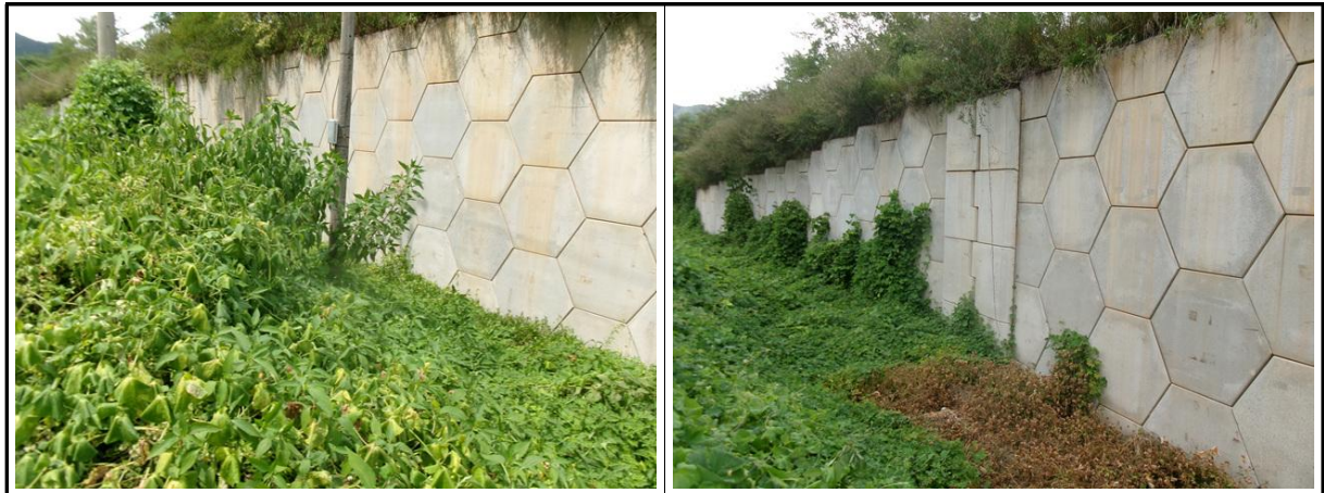
【사진 11.3.1】 지반, 기초부 전경
